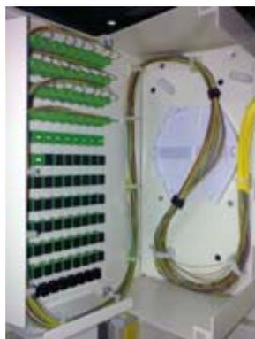
Paneles de distribución y mangueras pre conectorizadas
